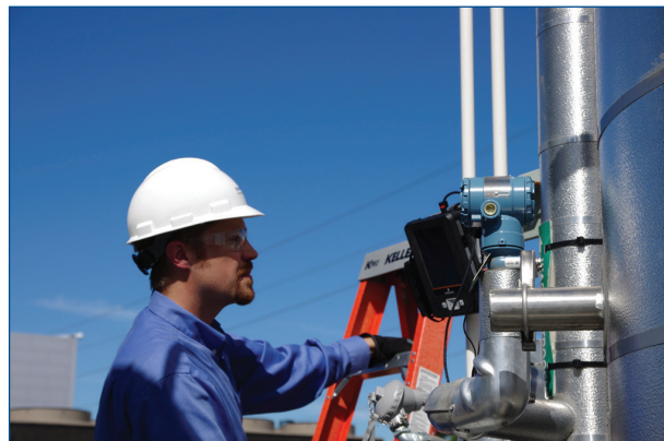
磁性挂件允许您将 Trex 单元固定在管道上，以释放您的双手进行其它工作。
